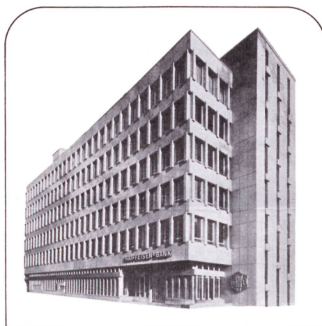
Sede dell'Unione Svizzera delle CASSE RAIFFEISEN a San Gallo, con Banca Centrale e Ufficio di revisione. Da qui parte il vasto servizio di consulenza e assistenza.
