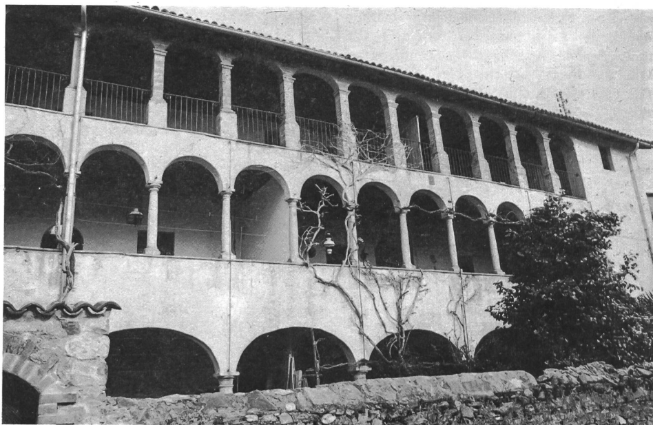
Casa patrizia a Monteggio.
