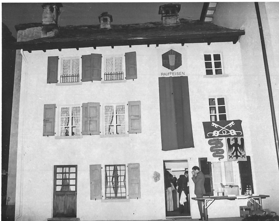
Il fabbricato che ospita gli uffici della Cassa. Ubicata sul piazzale Municipio, la sede può essere facilmente raggiungibile: un vasto posteggio è a disposizione dei clienti motorizzati. Per i primi mesi l'apertura è stata fissata nei giorni di lunedì e giovedì dalle ore 17.00 alle 19.00.
