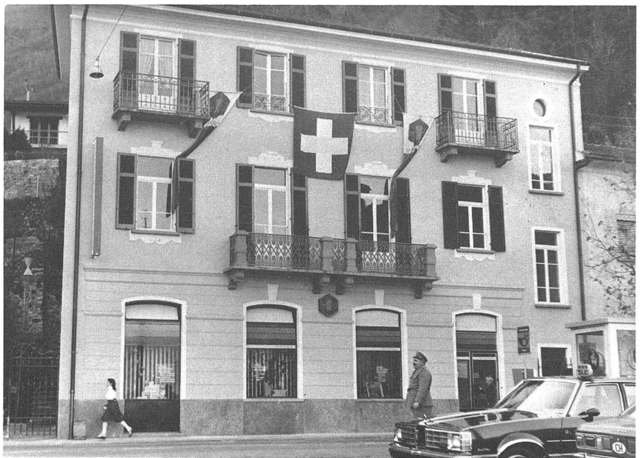
Lo stabile della Cassa Raiffeisen di Magadino, visto dal debarcadere. La sede è sistemata al pianterreno.
