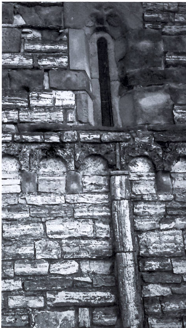
Particolare del fianco settentrionale della chiesa di San Martino a Mendrisio. Tutte le facciate sono state restaurate e rifatte: tuttavia questo lato è il più antico e vi si possono ritrovare tracce della primitiva costruzione longobarda.
