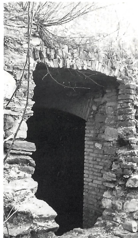
Ruderi del castello di Pontegana. Si vede una finestra, assai diroccata, e parte dell'interno, nel quale si notano alcune ricostruzioni.
