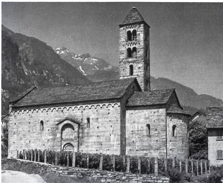
La chiesa romanica di San Nicolao a Giornico è del XII secolo. La struttura romanica, in robusta muratura di pietrame, è evidenziata dalle sobrie ornamentazioni esterne e dalle strette finestre. Poco distante dalla chiesa è il ricordo marmoreo della vittoria dei Ticinesi sui Lombardi nella cosiddetta battaglia dei Sassi Grossi (28 dicembre 1478).
