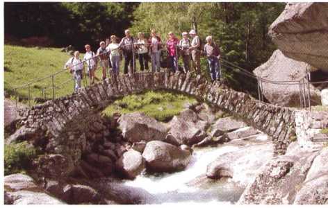
Una bella costruzione in sasso: il ponte sopra la cascata di Fogoglio.
