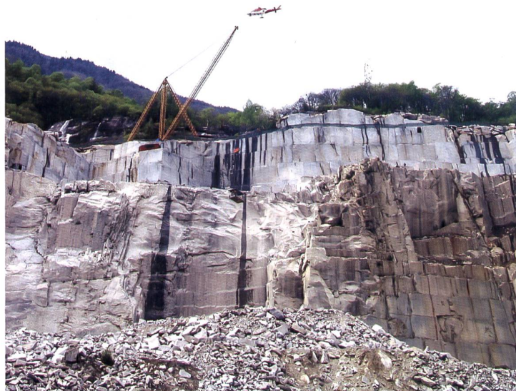
Panoramica zona d' estrazione durante la simulazione di evacuazione e soccorso.
