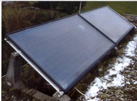
*I pannelli solari sul tetto coprono i due terzi del fabbisogno di acqua calda della famiglia. L'energia rinnovabile fa parte del programma Minergie-P.*
