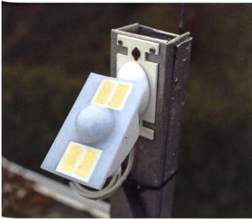
*In funzione del soleggiamento, un sensore sul tetto permette di attivare automaticamente le tende della casa.*
