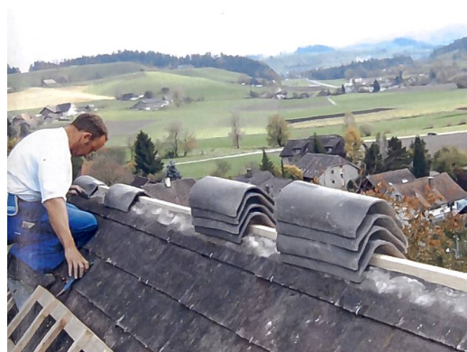
Durante la copertura del colmo del tetto non va trascurata l'aerazione.
