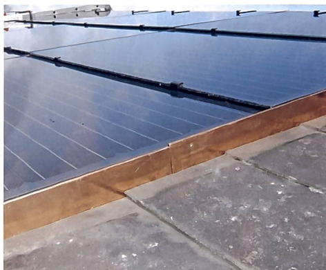
La posa scrupolosa dei pannelli solari e le rifiniture accurate garantiscono all'impianto una durata di 30 anni.
