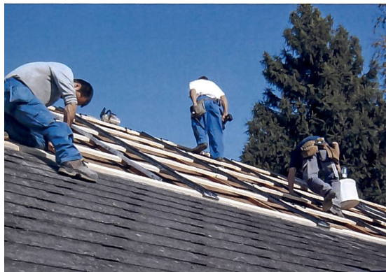
1° giorno: il personale di BE NETZ copre il tetto, posa le nuove assi, installa le grondaie.
