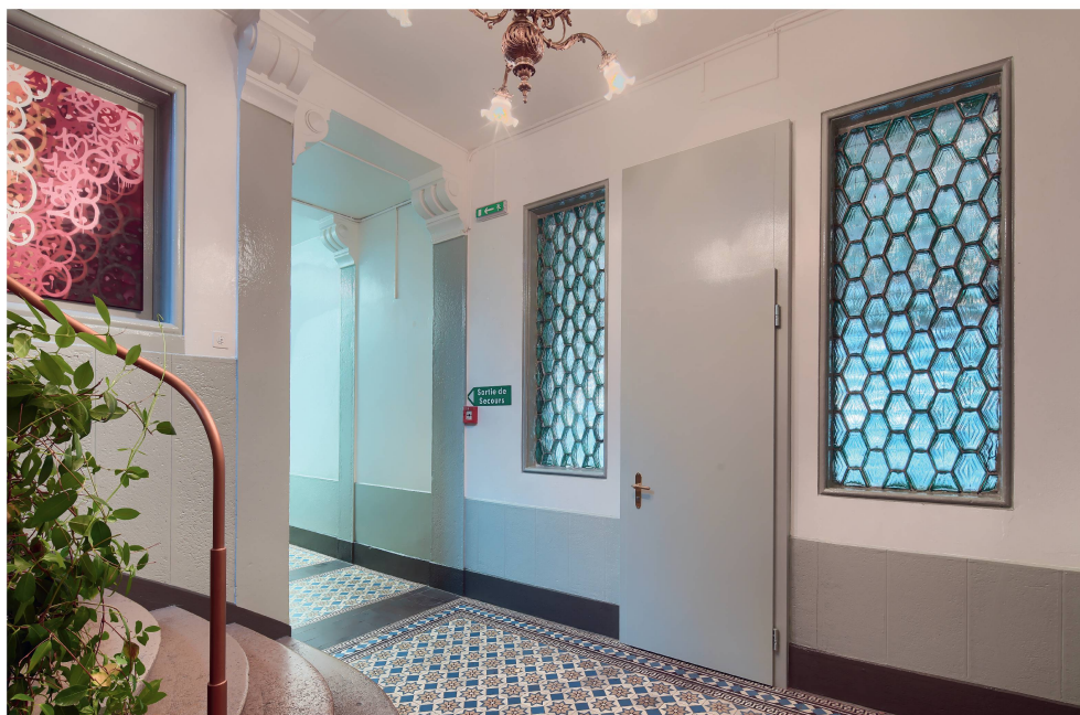
8 Territet, Les Jumelles, vue d'intérieur orné de briques Falconnier (photo Régis Colombo, 2017, Château de Nyon).
