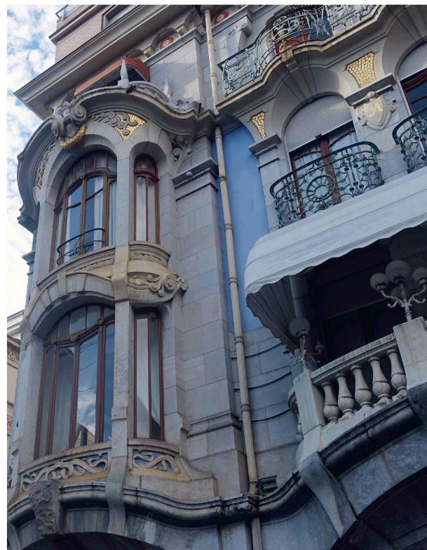
9 Hôtel Moderne, détail de la façade est (photo Catherine Schmutz Nicod, 2022).
