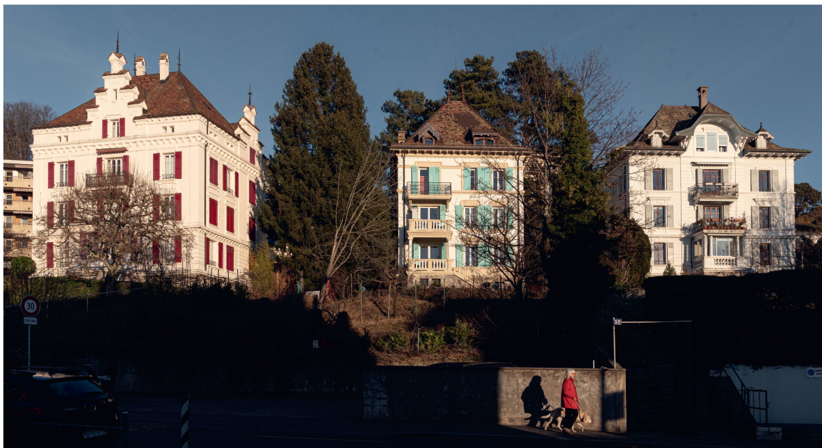
1 Lausanne, route du Pavement 30 à 34, les villas « Mont-Tendre », Chasseron » et « Le Salève », façades ouest, fin d'après-midi hivernal (photo Mona Joseph, 2022).
