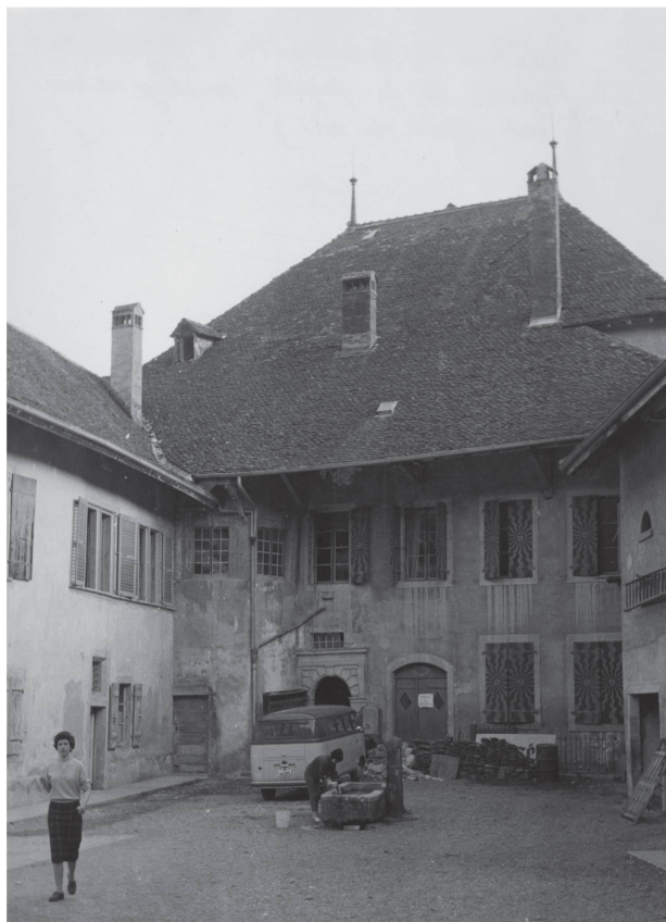
8 La façade nord de la Maison du Prieur à Romainmôtier, état avant restauration, vers 1961 (ACV, PP 549/1267/1).
