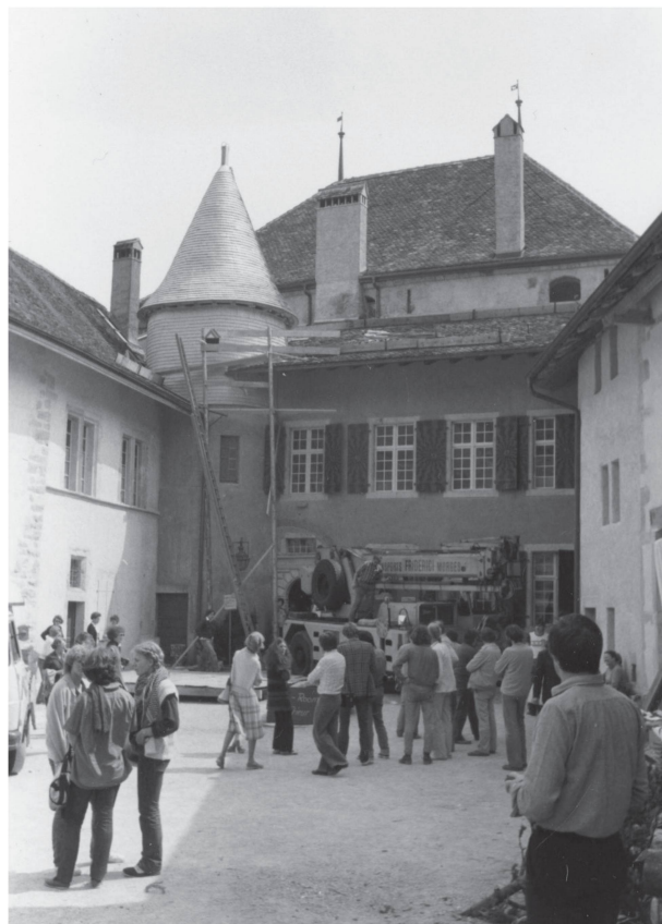
9 La façade nord de la Maison du Prieur à Romainmôtier, état après restauration, vers 1961 (ACV, PP 549/1212).
