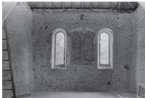
2-3 L'église réformée du Motty à Écublens, avant et pendant l'intervention des années 1960. On voit bien comment le temple est entièrement mis à nu et les dernières interventions supprimées (photo Pierre Margot, ACV PP 549/1181/1).
