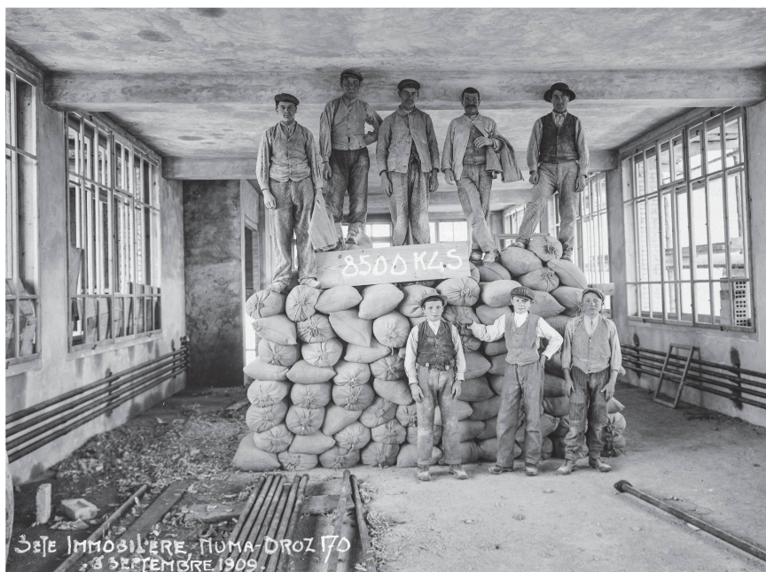
7 René Chapallaz, photographie d'essai de surcharge de plancher dans la fabrique Clairmont, 1909, négatif souple transformé en positif par Photoshop, 16 x 21 cm (VCH-BVFSP RC).
