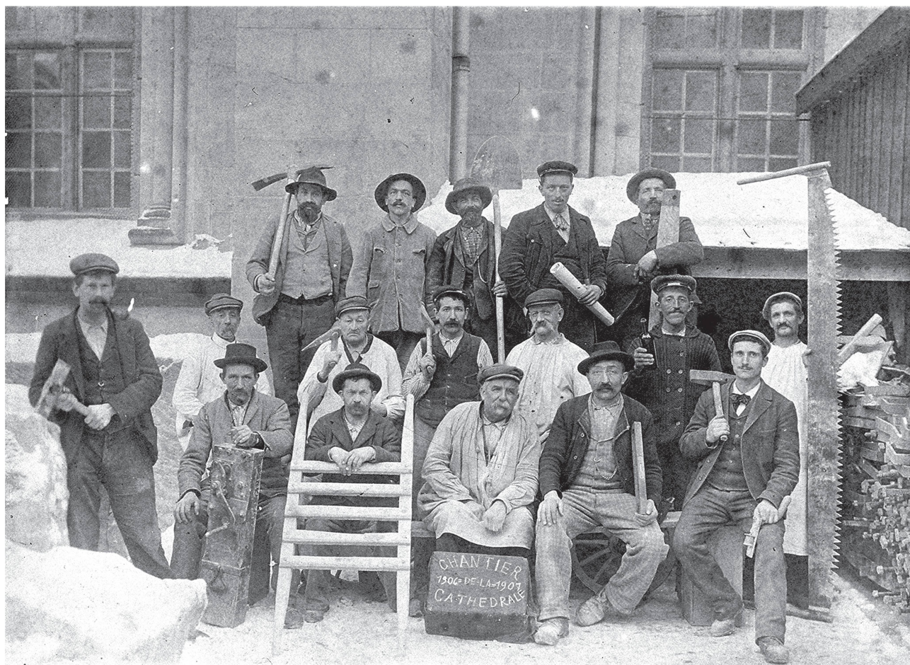
1 Portrait collectif des ouvriers du chantier, posant au pied du bas-côté nord de la nef de la cathédrale de Lausanne, 1906-1907 (ACV, SB 52 Aa/96/2).
