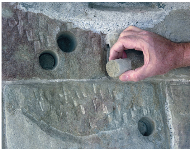
5 Purges et remise en place de la substance des carottages en 2007 (Documentation photographique de la Ville de Genève, Photo Claudio Merlini).
