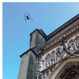
Relevé photogrammétrique par drone
