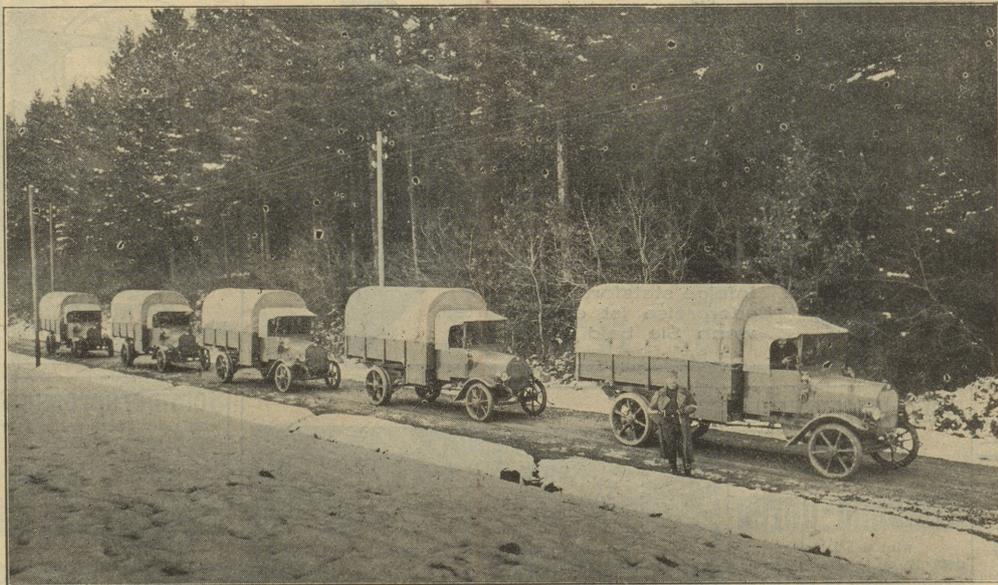
Lastzüge bis 10 Tonnen Tragkraft
