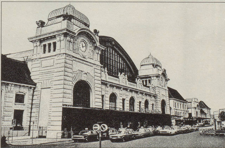
Der SBB-Bahnhof Basel danach.
