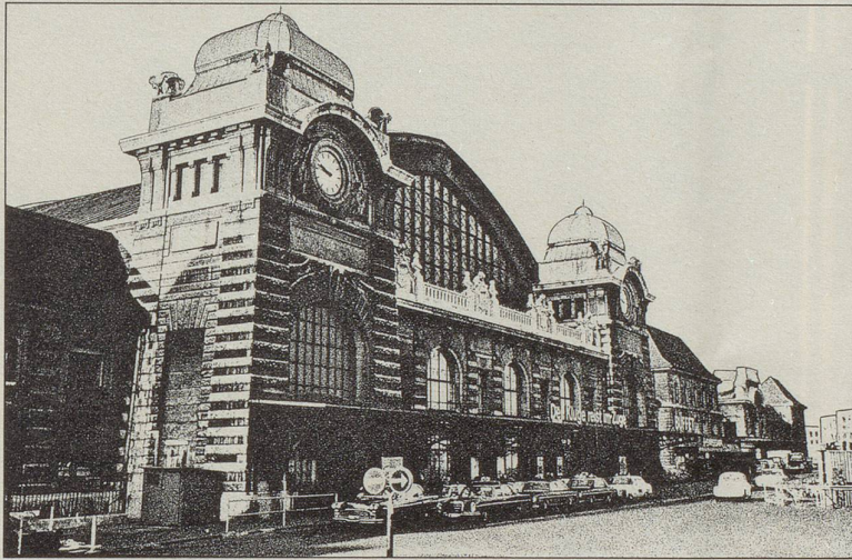
Der SBB-Bahnhof Basel vor der grossen Wäsche.
