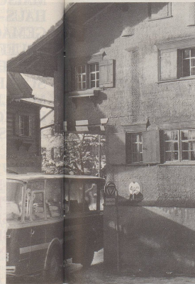
6 In diesem Haus verbrachten Goethe und Frau von Stein bei ihrer Durchreise nach Italien zwei Nächte. Subtil haben die Planer das denkmalgeschützte Gebäude der Linienführung der neuen Strasse angepasst.
