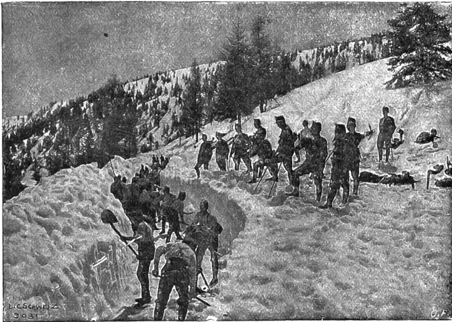
Von der Grenzwehr 1917. — Schneebrucharbeiten im Tessin.
