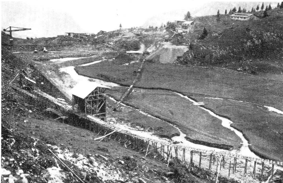
Der Bannalp-Kraftwerk-Bau im August 1936.
