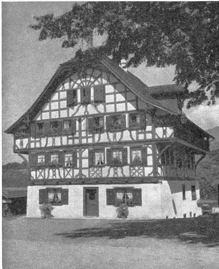
Die alte „Krone“ von Sachseln prachtvoll renoviert
