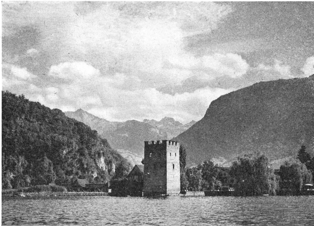
Der Schnitzturm in Stansstad
