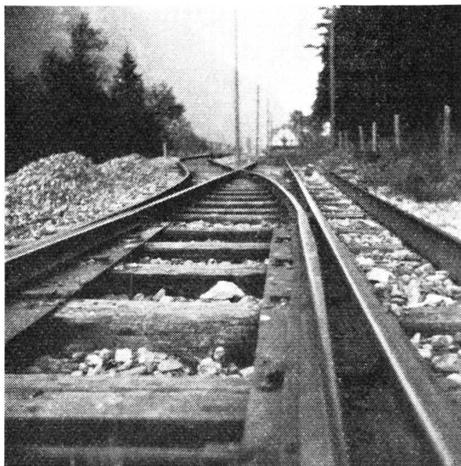
Das Trasse und die Schienen für die Aa-seitige Umfahrung der Parketterie zwischen Dörfli und Grafenort sind erstellt.
