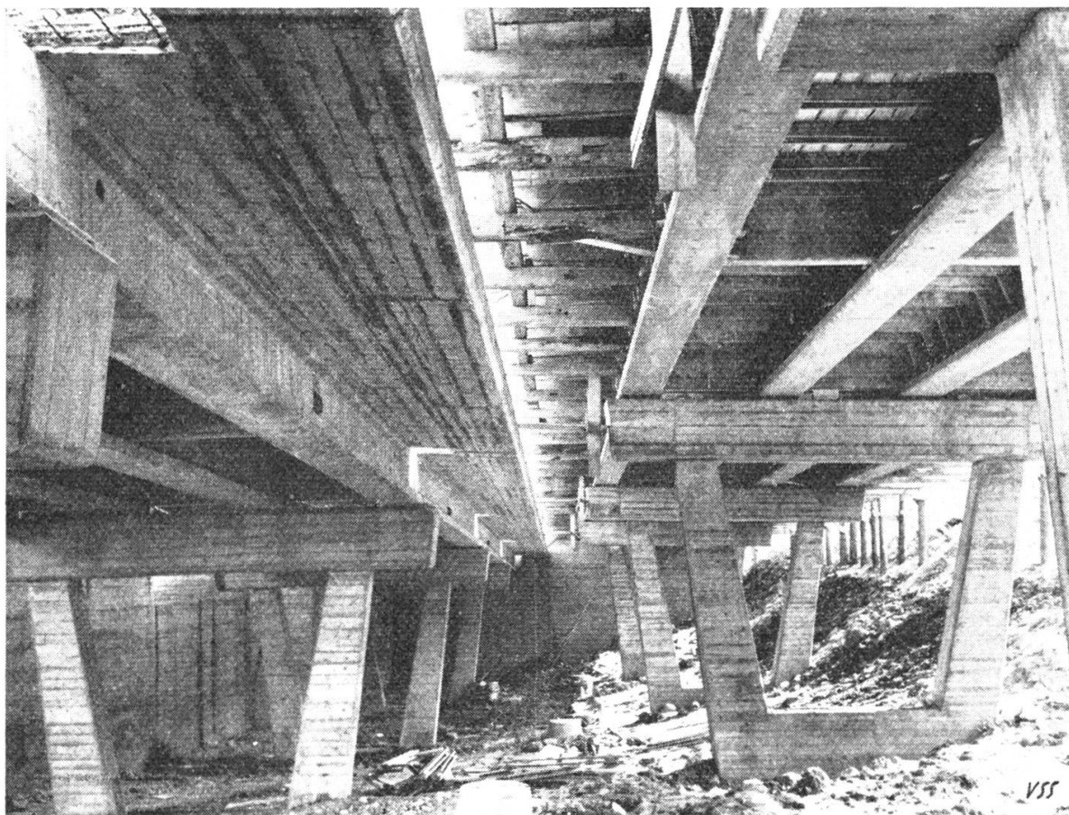
Die elegante, vorfabrizierte Zwydenbrücke soll den rutschigen Grund möglichst wenig belasten.
