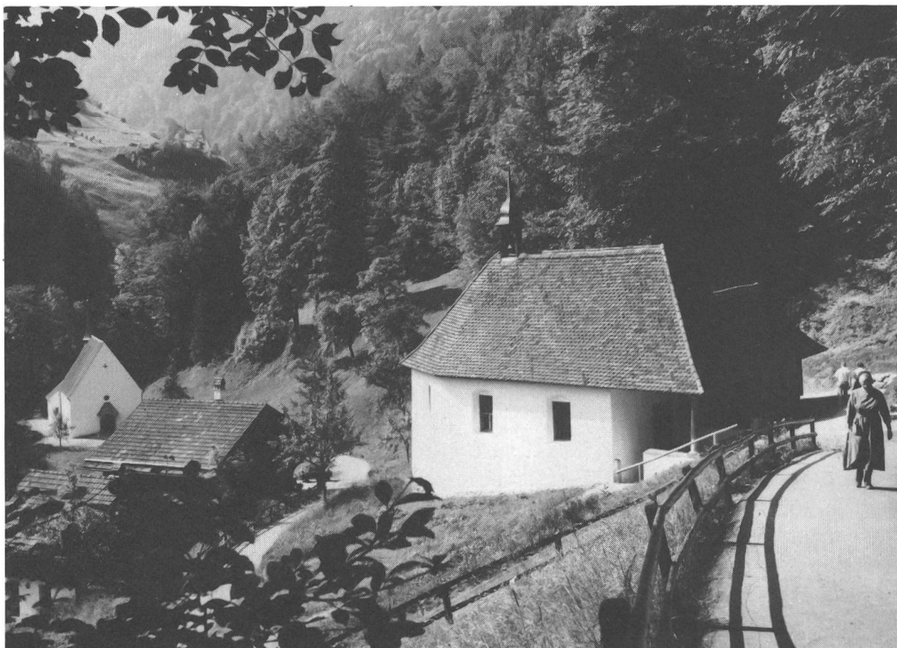
Der Ranft und seine Bauten: rechts die obere, links die untere Ranftkapelle, dazwischen erkennbar das Dach des Sigristenhauses.
