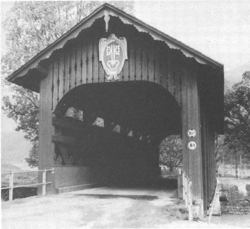
14. In Buochs kann die Fadenbrücke , die im Unterbau ein neues Holzwerk und eine Totalrenovation erhielt, wieder dem Verkehr übergeben werden. Das Anbringen des Nidwaldner Wappens war sozusagen der i-Punkt und Abschluss der Arbeiten.
