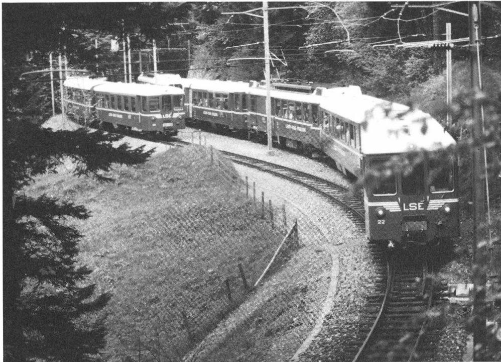
Kreuzung zweier Pendelzüge im Ghärst. Diese Ausweichstelle wird ausgebaut damit auch lange Züge problemlos kreuzen können.
