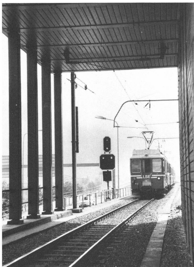
Galerie am Lopper, die nach dem Felssturz von 1973 erstellt wurde.
