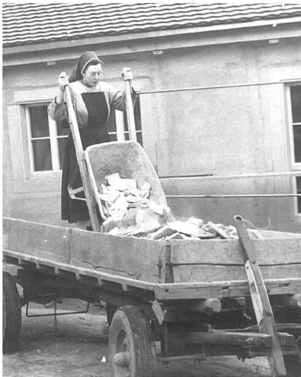
Bei der Renovation wurde alles, was die Schwestern selber tun konnten aus Gründen der Sparsamkeit selber ausgeführt.
