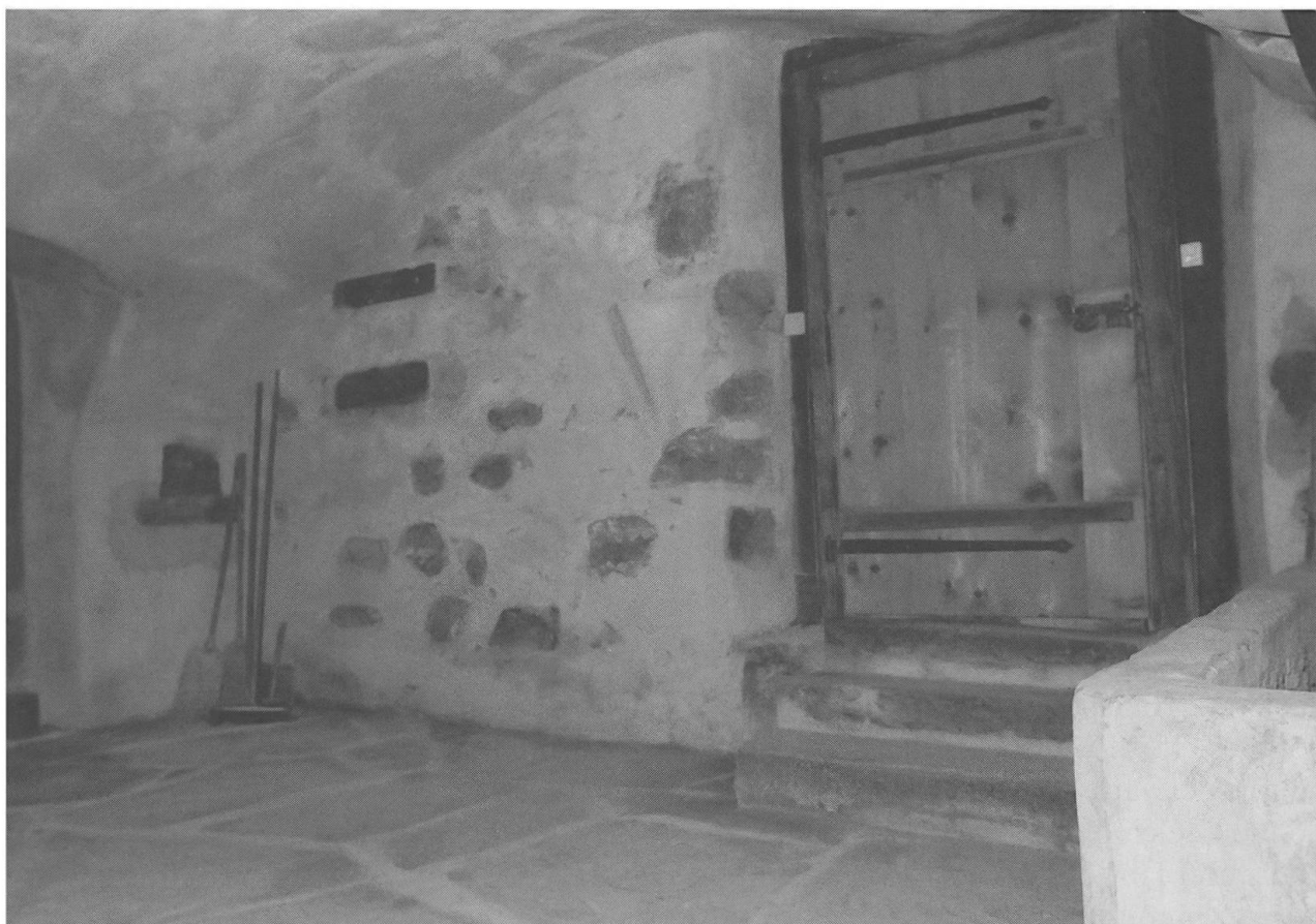
Im gewölbten Keller sieht man links das «Lichtloch». Dort konnte man beim Gang in den Keller eine Kerze so hinstellen, dass sie sicher keinen Brand verursachte.
