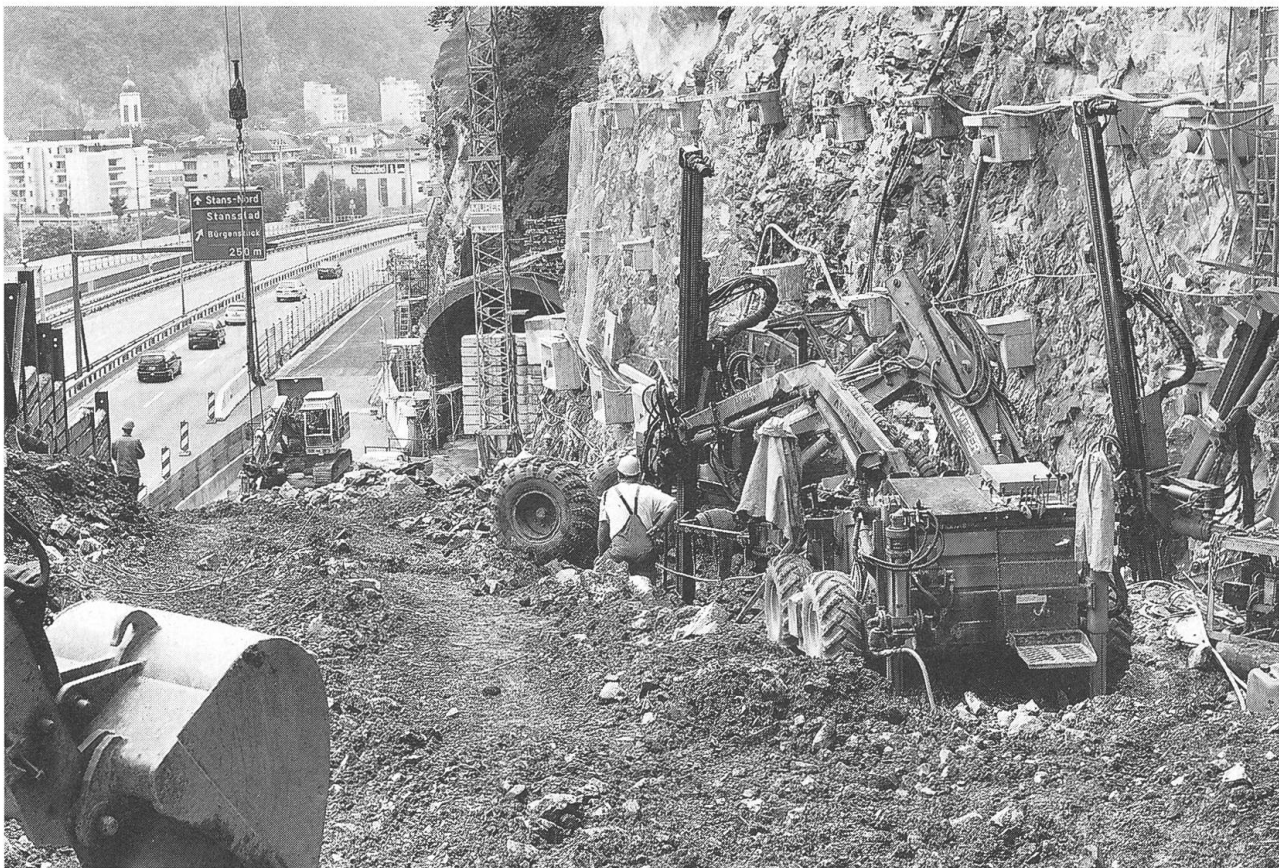
Die Portalzone des Kirchenwaldtunnels auf Stansstader Seite.
