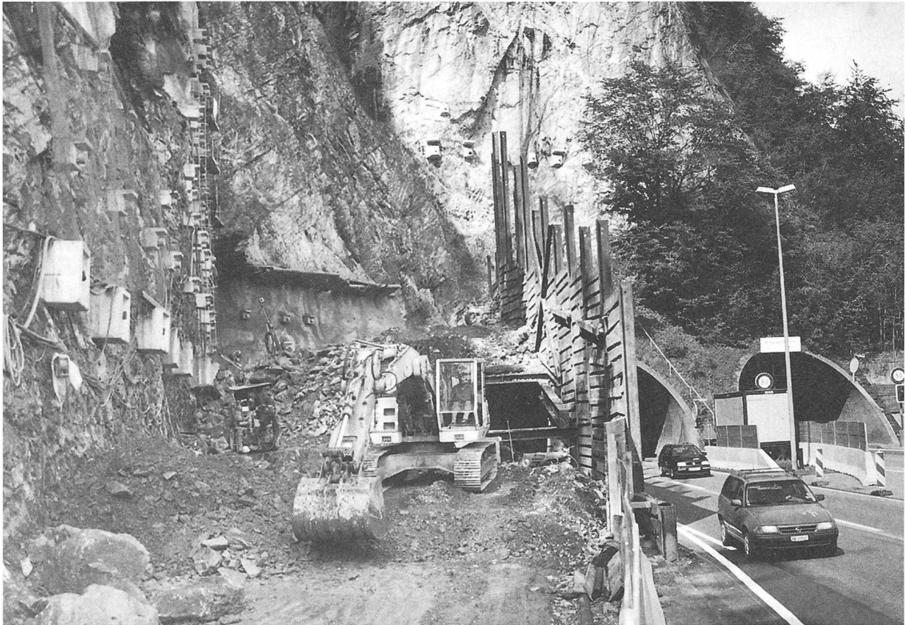
Der Felsabtrag für das Portal des Kirchenwaldtunnels bei Acheregg.
