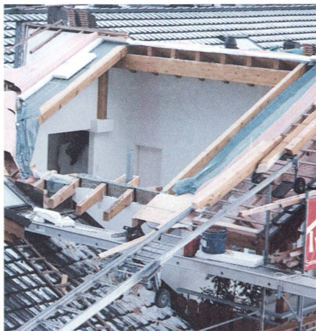
Dachreparatur nach Lothar
