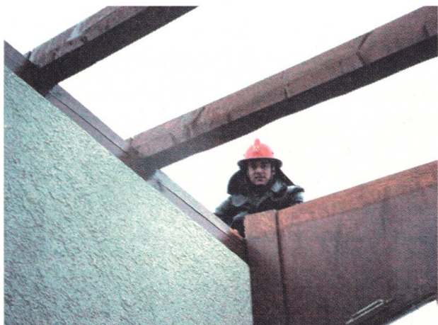
Feuerwehr Emmetten deckt Dächer ab.
