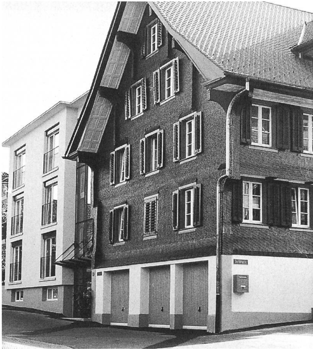
Ansicht von Nordwesten nach der Restaurierung mit rückwärtigem Neubau.
