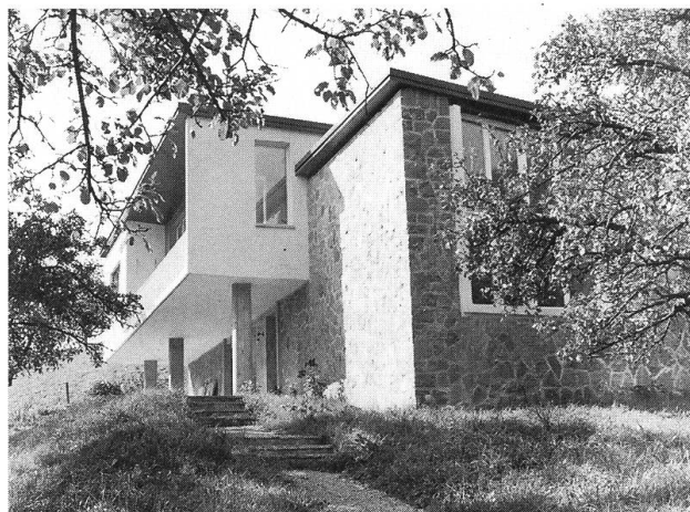
Stans. Haus Stöckli, Rotzhalde. Aussenansicht von Südosten.
