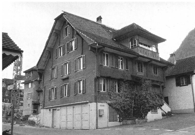
Buochs. Wohnhaus Dorfstrasse 13. Ansicht von Nordwesten. Zustand vor der Restaurierung.
