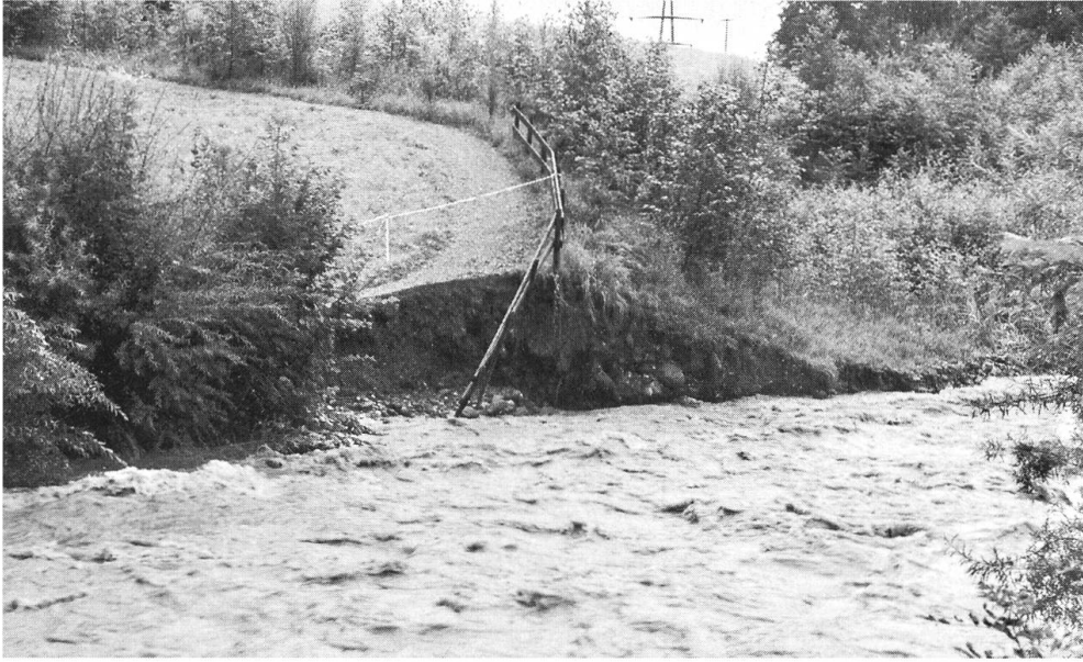
Einer der Uferanbrüche hat an dieser Stelle den Bikeweg nach Engelberg unterbrochen.
