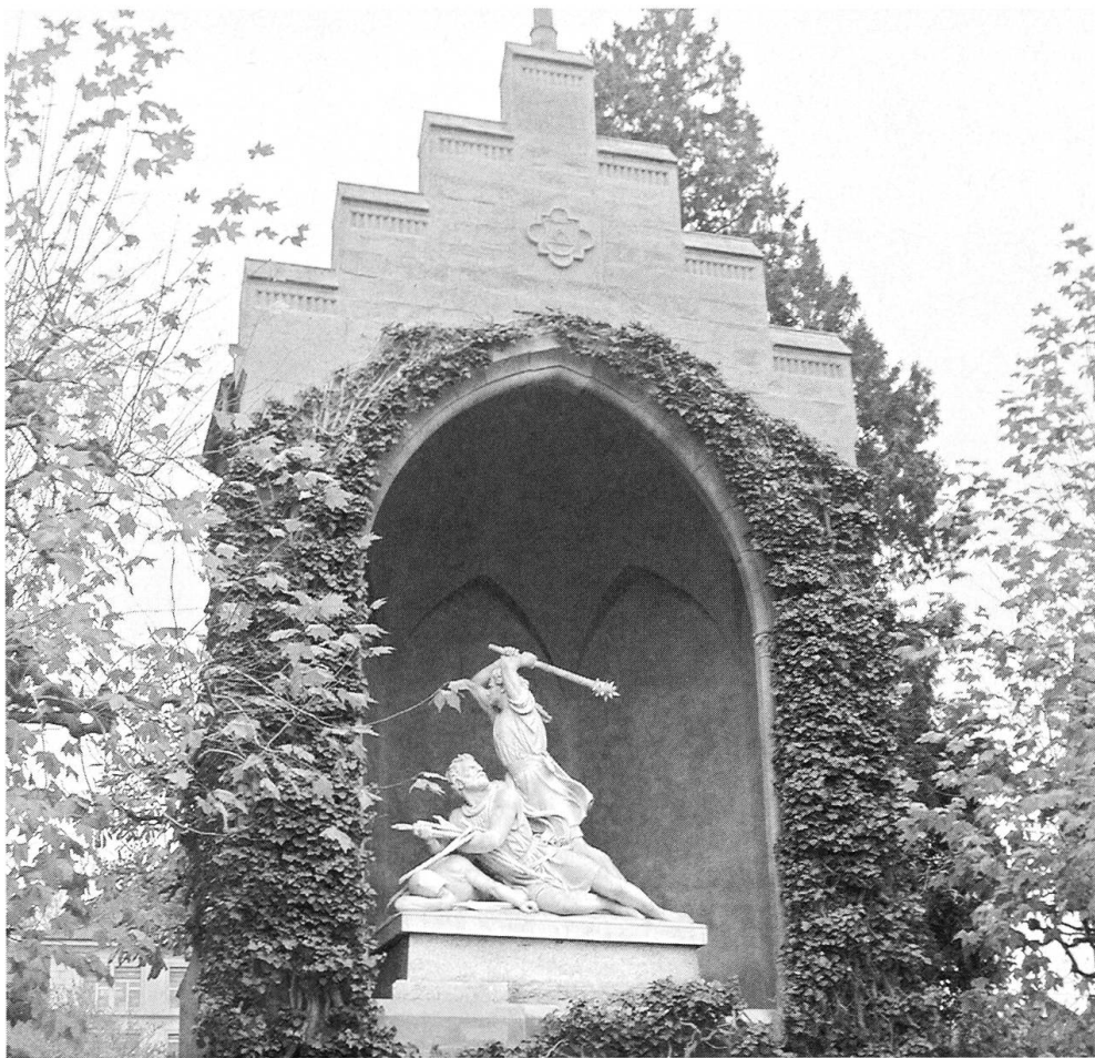
Stans. Winkelrieddenkmal, Restaurierung
