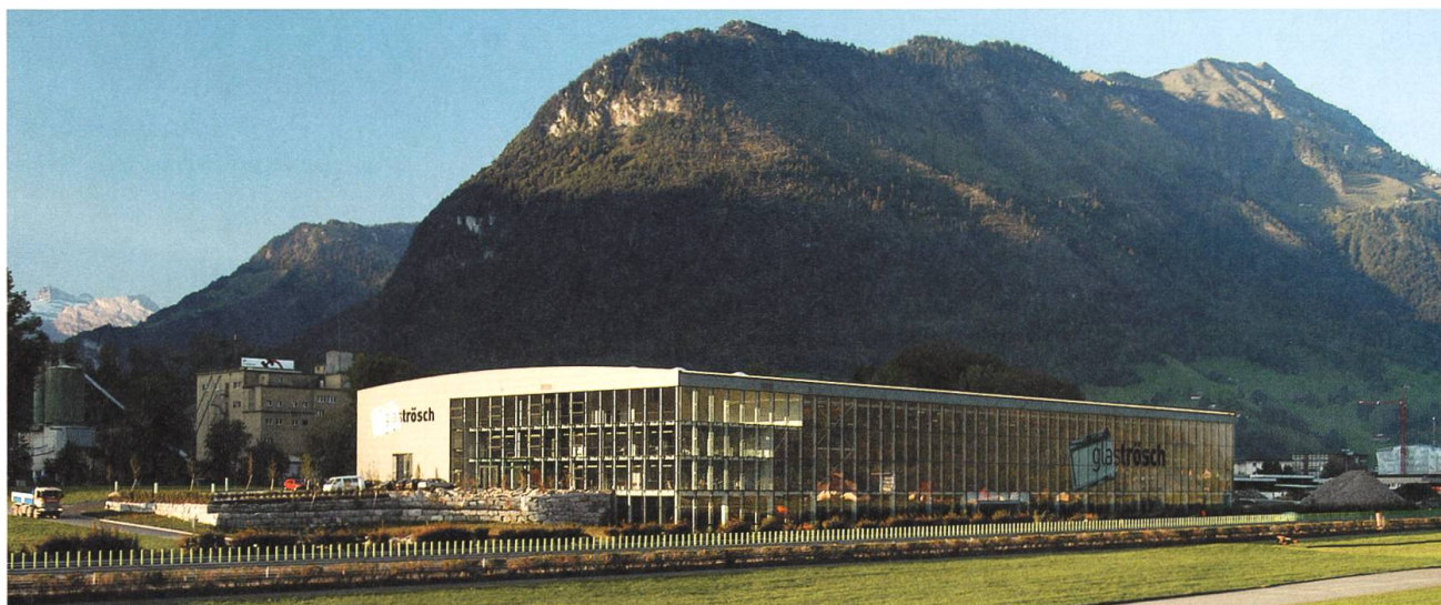
Das neue Produktionswerk in Buochs
