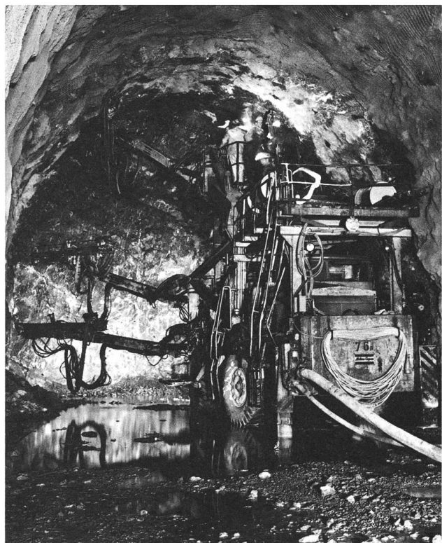
Bohrmaschine im Loppertunnel.
