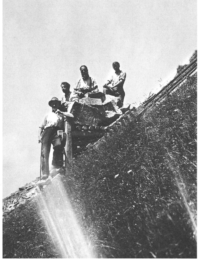
Die Steinblöcke wurden aus einem «Steinbruch» im Gebiet Gigi mit einer eigens konstruierten Bahn zum Bauplatz gebracht.
