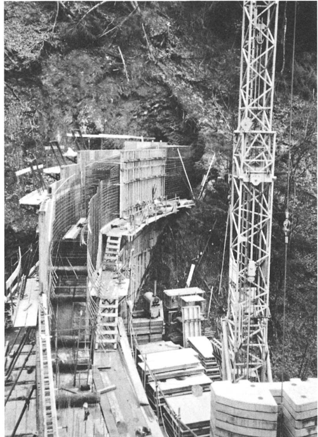
Erhöhung der Sperre beim westlichen Arm Hinter-Erlibach IV an der Werkstrasse 3
