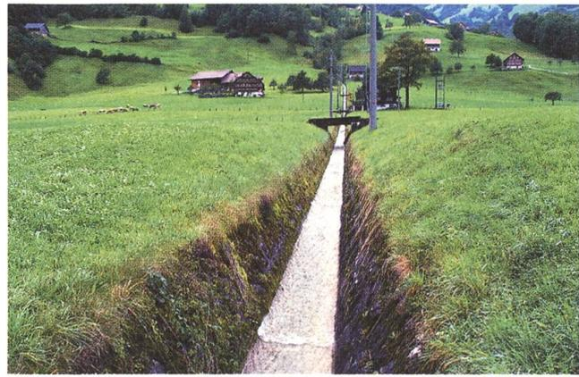
Abbildungen 9 bis 10. Dem Scheidgraben Buochs/Ennetbürgen (links) kommt in diesem Abschnitt die Einstufung «stark beeinträchtigt» zu. Gründe dafür sind: keine Sohlen- und Wasserspiegelvariabilität, verbauter Böschungsfuss, kein Uferbereich, keine Bestockung. «Naturfremd, künstlich» ist die Klassierung des Krätligbaches in Dallenwil (rechts). Ihm fehlen in diesem Abschnitt alle Eigenschaften, die einen funktionierenden Bach in ökologischer Hinsicht ausmachen.
