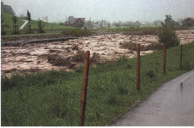
Die im Rahmen des Hochwasserschutzes realisierten Massnahmen von der Bürerbrücke bis nach Buochs haben sich bei diesem Jahrhundert-Hochwasser bewährt.
