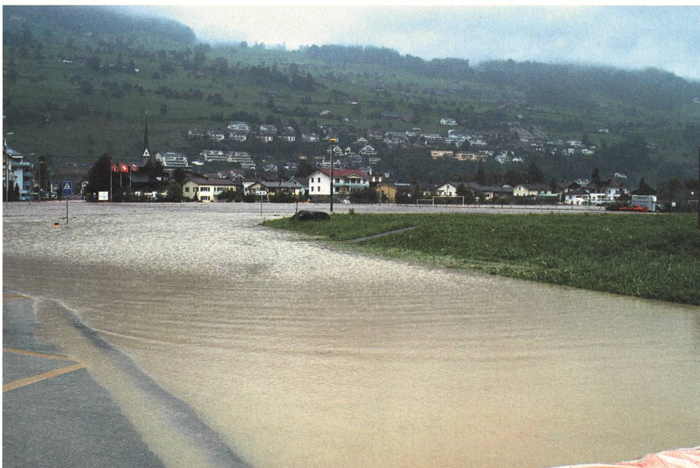
Die Entlastungsmassnahmen führten dazu, dass ein Teil der Wassermenge zwischen Buochs und Ennetbürgen einen Weg zum Vierwaldstättersee suchte.
