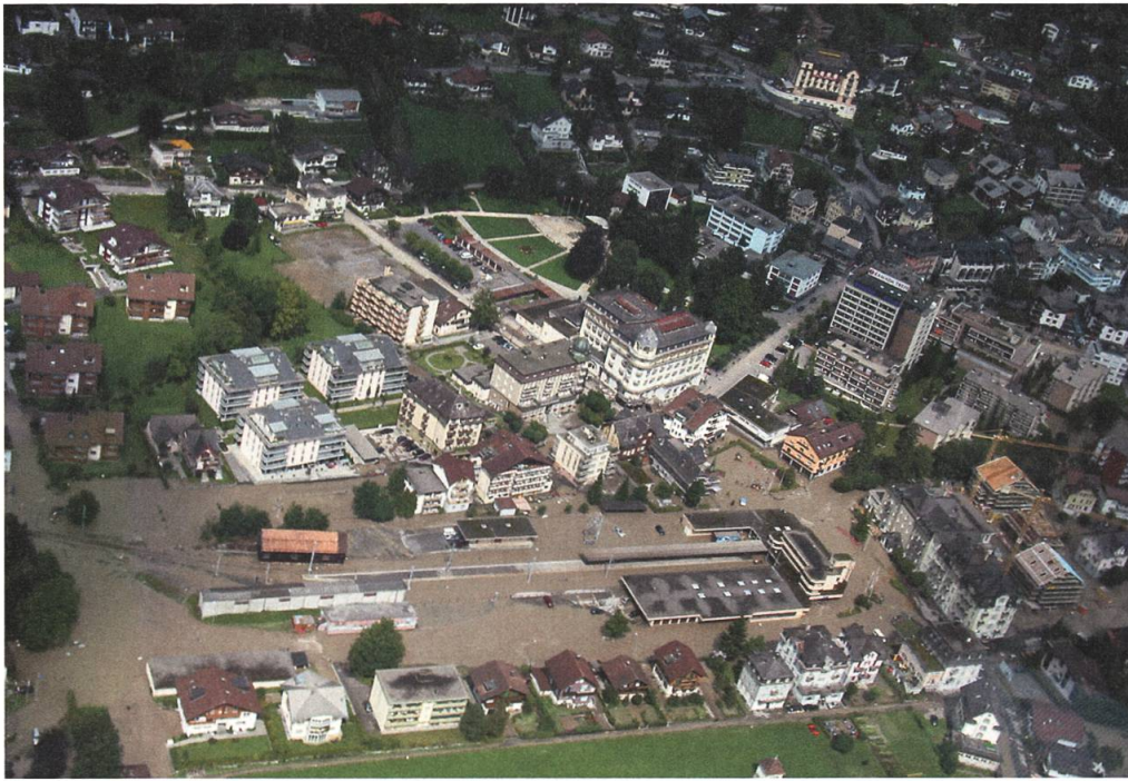
Engelberg am Tag nach den grossen Regenfällen. Der Bahnhof steht immer noch bis zu einem Meter unter Wasser.
