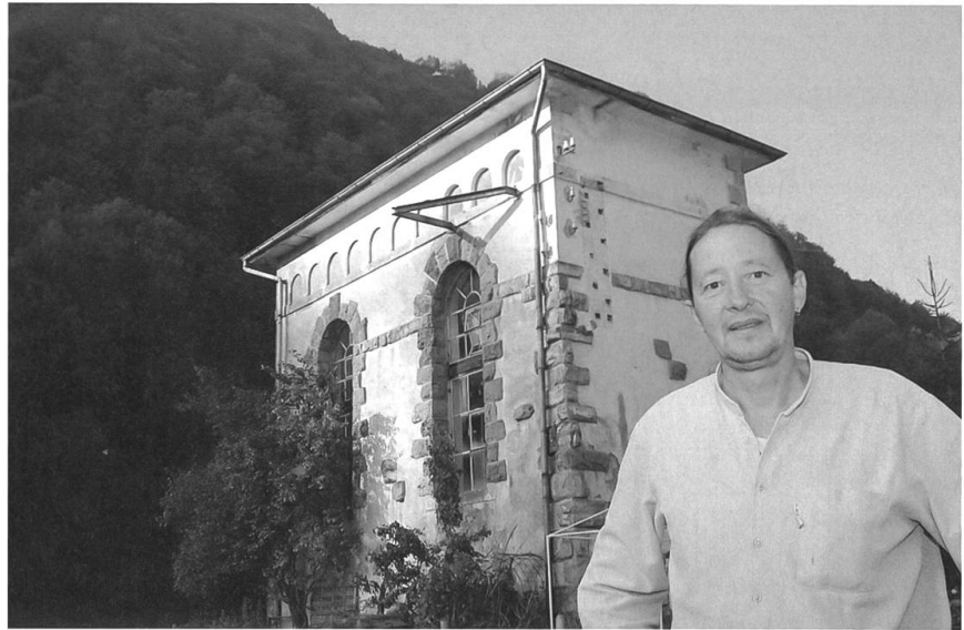
23.10. Trafostation wird Kultur-Turm.
