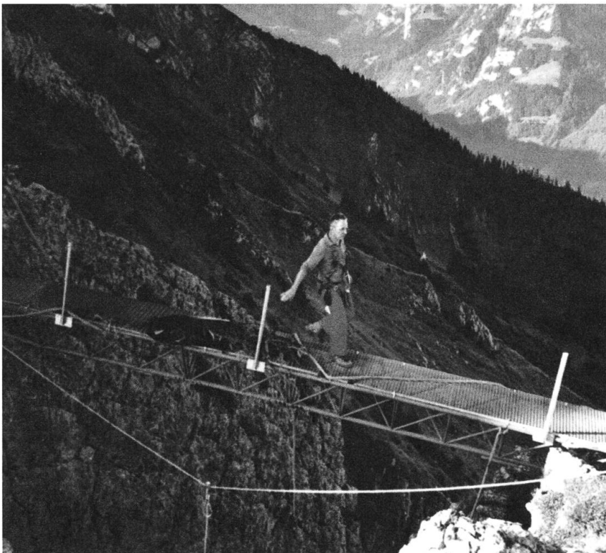
2.10.06 Herzstück ist eingebaut
