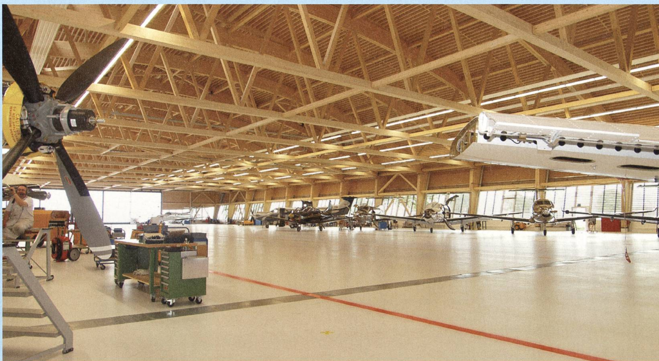
Gross, hell, umweltfreundlich und ohne Tragsäulen: Die neue Montagehalle bietet Raum für 200 Arbeitsplätze und sechzehn PC-12.
