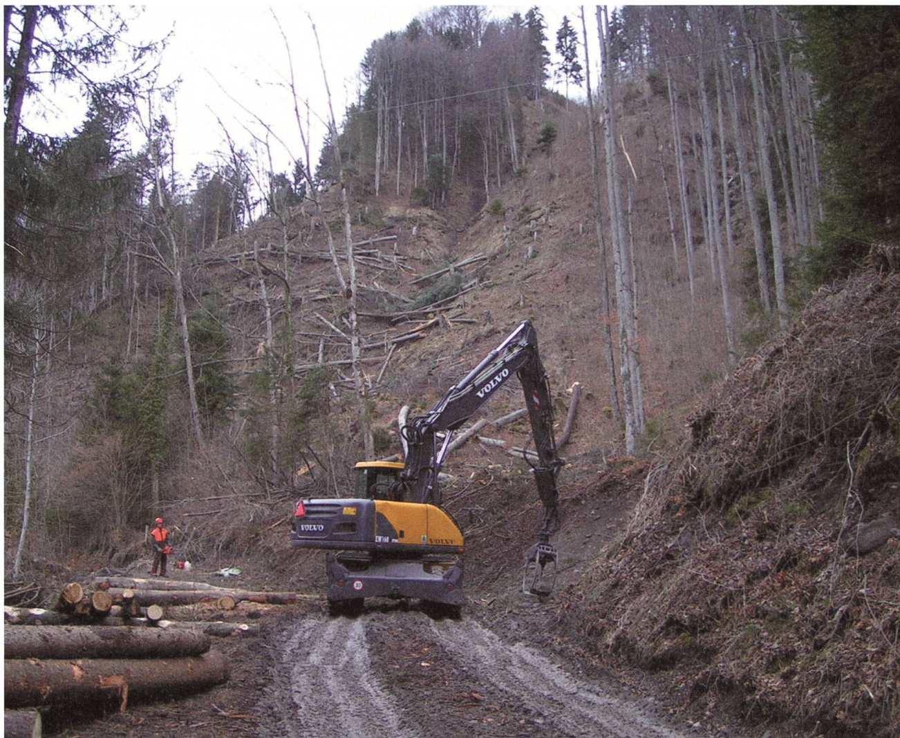
Die Uertekorporation Dallenwil investiert jährlich bis zu 100'000 Franken in die Pflege der Dallenwiler Schutzwälder.
