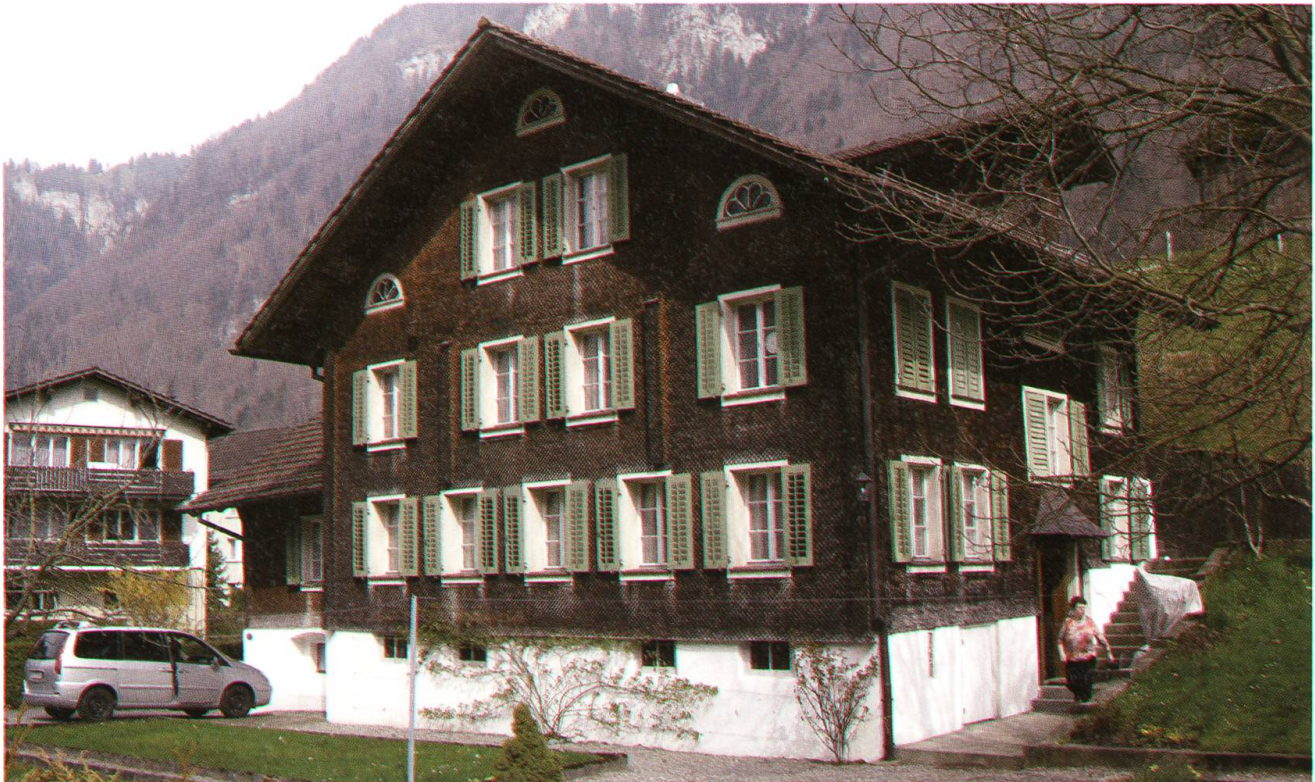
Das bestehende Wohnhaus beim Hubel in Wolfenschiessen wird durch einen neuen Holzbau ersetzt.
