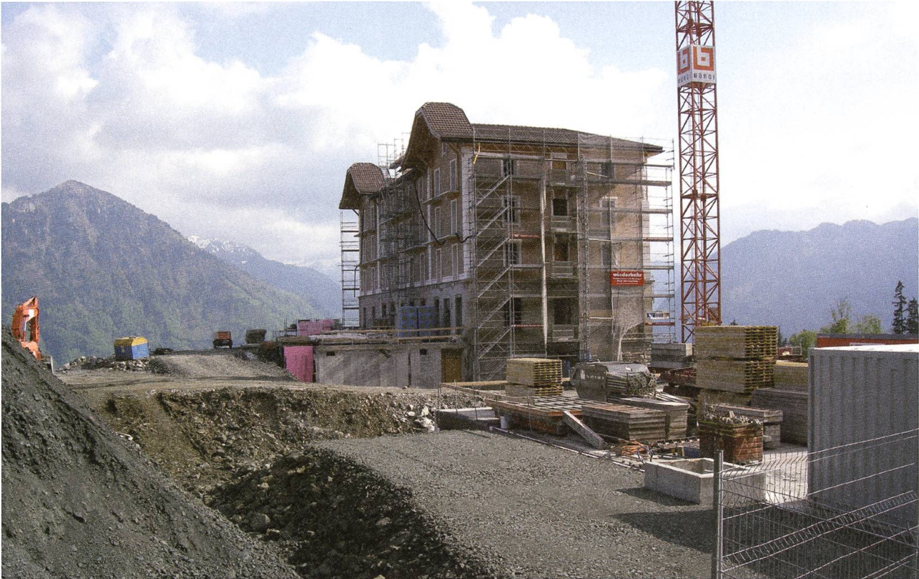
Die Landschaft rund um das Hotel Honegg auf dem Bürgenstock wird vollständig erneuert und als Park ausgestaltet.
