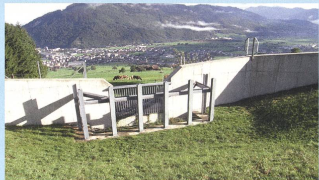
A: Der Geschiebesammler hält Steine und Stämme auf und bremst das Fliesstempo des Wassers.
