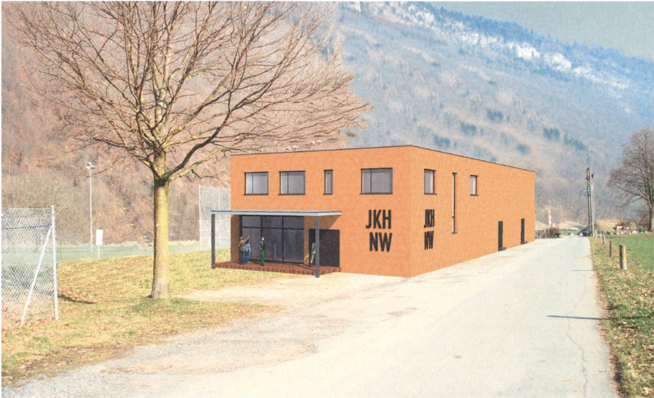
Computeranimation: So sieht der Senkel aus, wenn er fertig gebaut ist.
